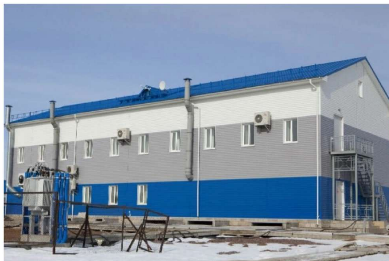
Астраханская область, Красные Баррикады ПС 110 «Баррикада»
